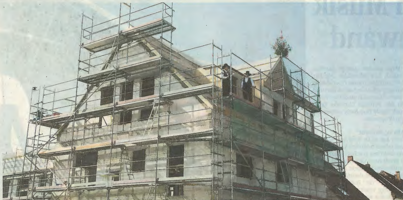
Richtspruch vom Dach: Die Zimmermänner Christian Bock und Christoph Wiedmann sprachen gestern Vormittag beim Richtfest des neuen Kastanienkindergartens in der Hemsbacher Gartenstraße.
