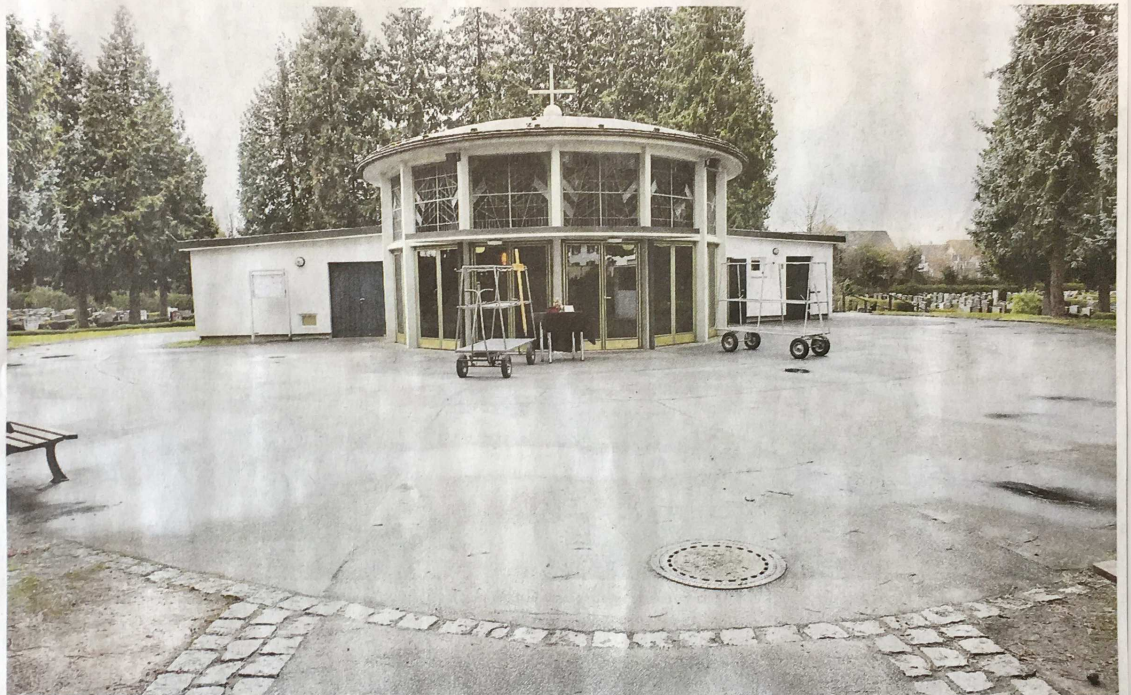
Der Anfang ist gemacht: Der Gemeinderat will ein Vordach an die Trauerhalle bauen und verwarf einen Laubengang.
