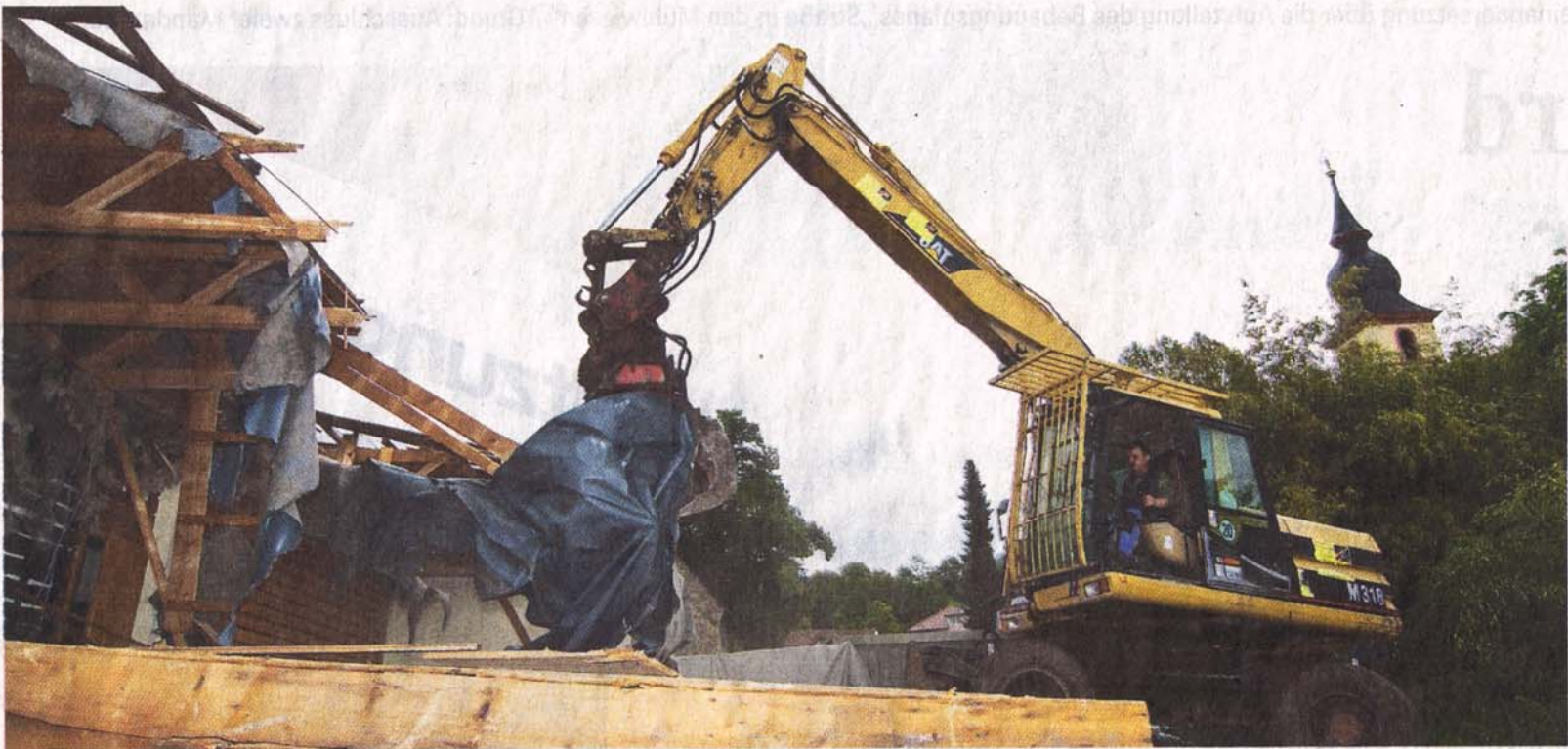
Der Sortiergreifer des Baggers holt sich eine Plastikplane aus dem Dach des Kindergartenbaus: Beim Abbruch des Gebäudes wird behutsam vorgegangen.
