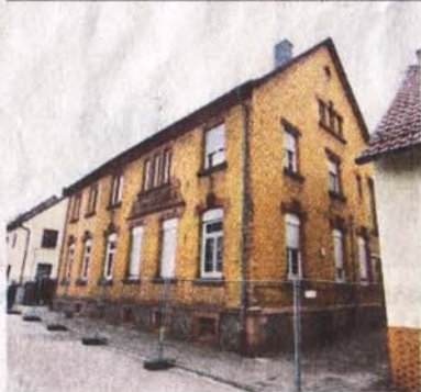
Ein letztes Bild vom Kastanien-Kindergarten: Am Montag beginnt der Abriss des Hauptgebäudes.
