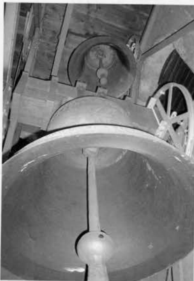
Zum Tag des offenen Denkmals am 8. September: Blick in den Turm und Dachstuhl der St.-Laurentius-Kirche
